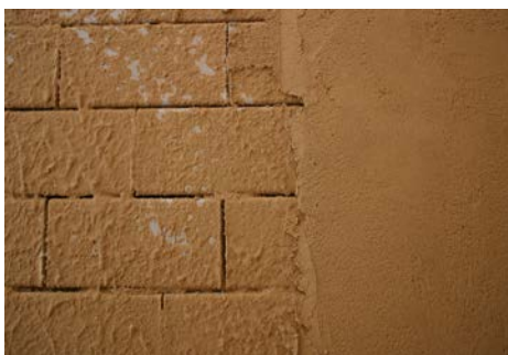
Zdivo se omítá hliněnou omítkou.
