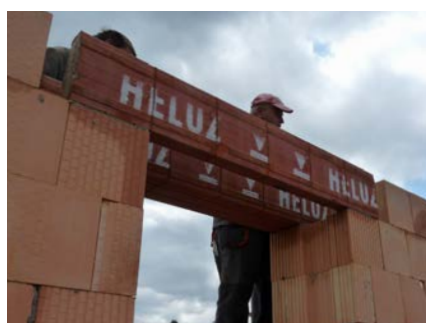
Uložení překladů (překlady HELUZ 23,8) do maltového lože.
