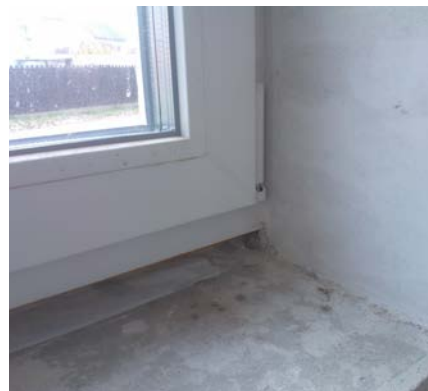
⑪ Pohled na styk parapetu a ostění po provedení omítek a před osazením finálního vnitřního parapetu.
