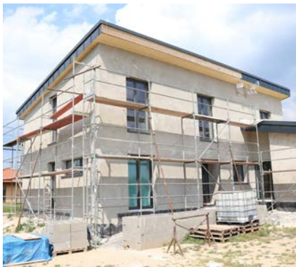
⑤ Provedení jádrové omítky (lehčenné nebo tepelněizolační).
