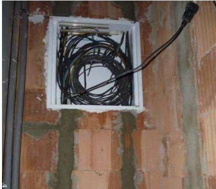
Rozvody by před omítnutím měly být řádně zapraveny maltou.
