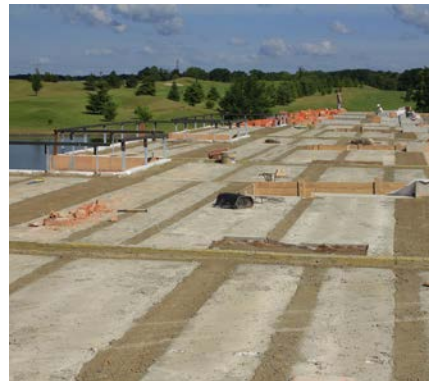
③ K betonáži styčných spár mezi panely se použije beton s maximální velikostí zrna 4 mm pevnostní třídy min. C16/20 - XC1 měkké konzistence S3 dle ČSN EN 206-1.
