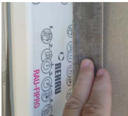
⑨ Přilepení okenních omítatelných pásek.
