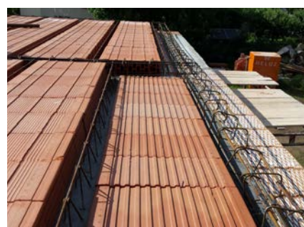
Provedení ztužujících věnců.
