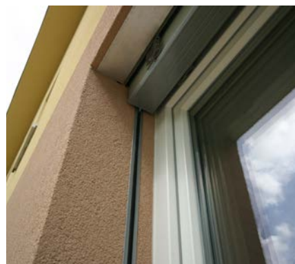
⑭ Pohled na finální provedení stavebního otvoru se žaluzií v roletovém a žaluziovém překladu HELUZ.
