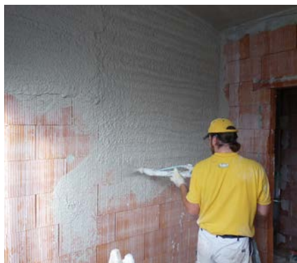
① Strojní nanášení vnitřní omítky.
