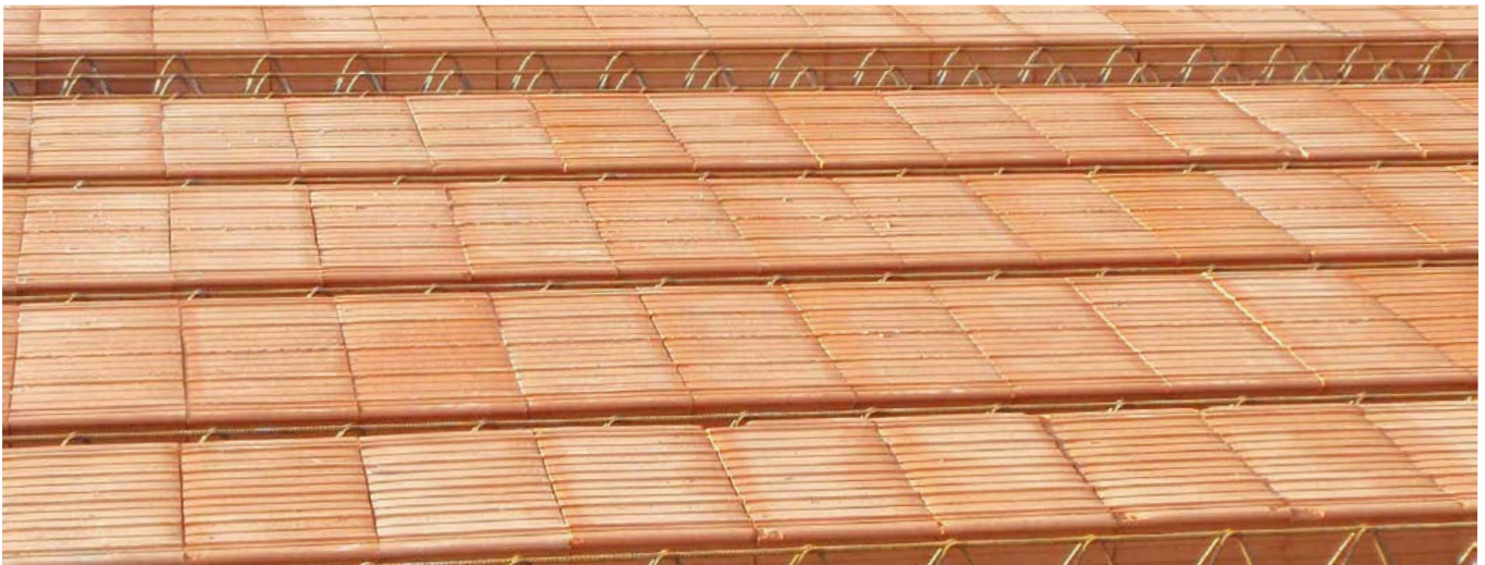
Pohled na uložené nosníky a vložky (před uložením KARI sítí)
