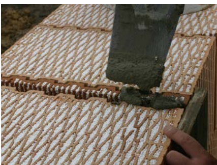
Mezeru mezi cihlami, je nutné vyplnit maltou nebo dořezem cihly a promaltováním (v případě zdění na PU pěnu propěněním dvěma pruhy).
