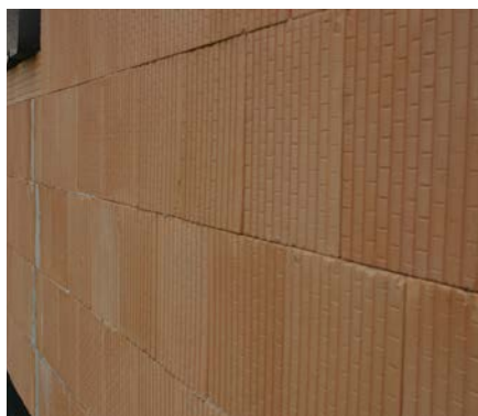
Podklad zdiva pro omítky měl by být rovný.
