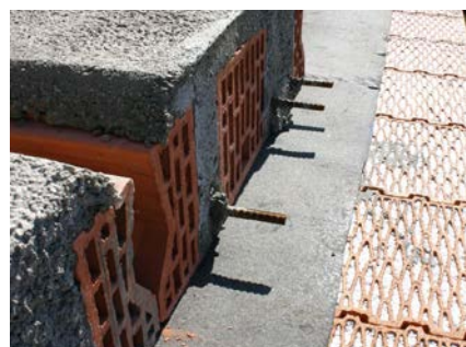
Uložení stropů na asfaltový pás.
