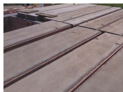
Podpěření stropů MIAKO + nadvýšení / pokládka stropních panelů.
