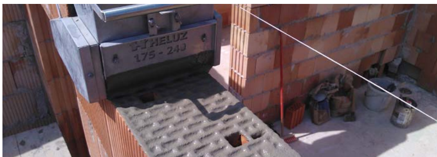
Zdění vnitřních nosných stěn.
