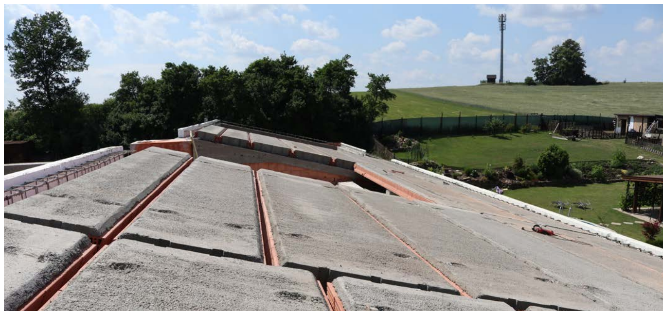
③ K betonáži styčných spár mezi panely se použije beton s maximální velikostí zrna 4 mm pevnostní třídy min. C16/20 - XC1 měkké konzistence S3 dle ČSN EN 206-1.
