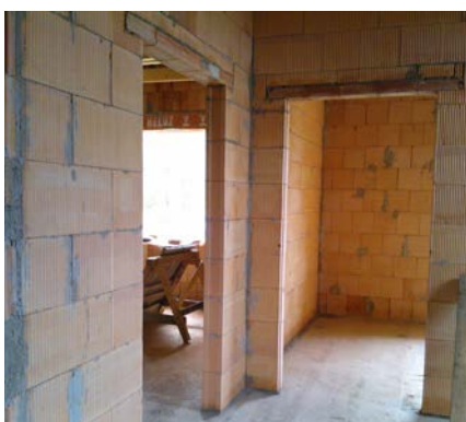
① Ostění stavebních otvorů ve vnitřním zdivu se zakončuje drážkami popř. pery cihel.
