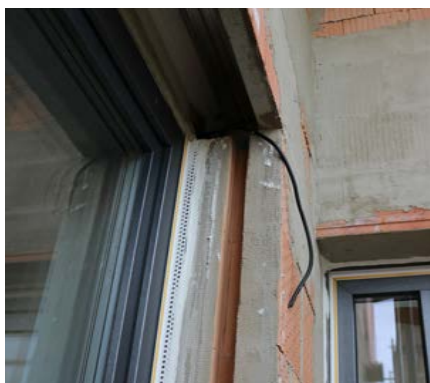
⑫ V případě použití roletových překladů je možné vyříznout v doplňkových cihlách dráž- ku pro vodící lišty stínící techniky.
